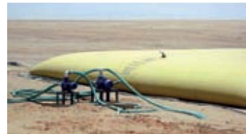
200 m 3 agua de obras
